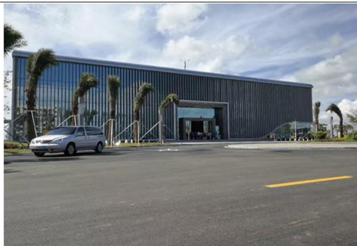
项目东南侧展示中心
